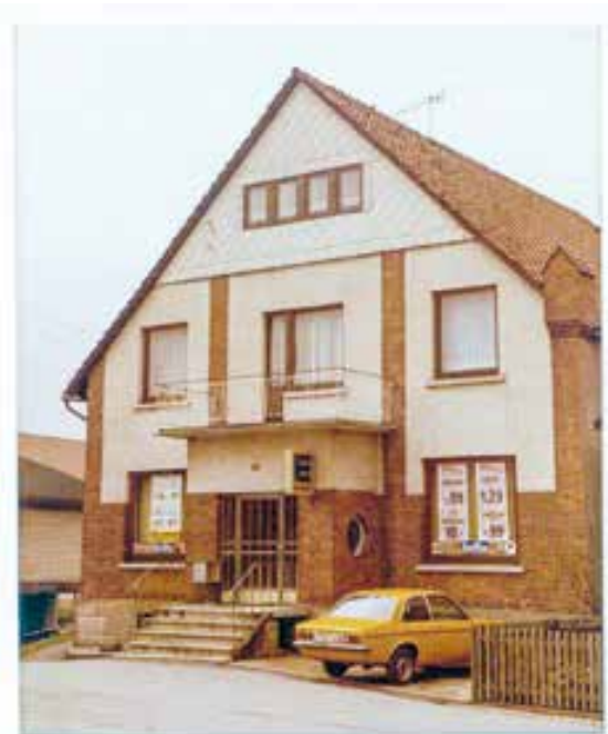
... wurde ersetzt. Dafür war nun ein Balkon da.
